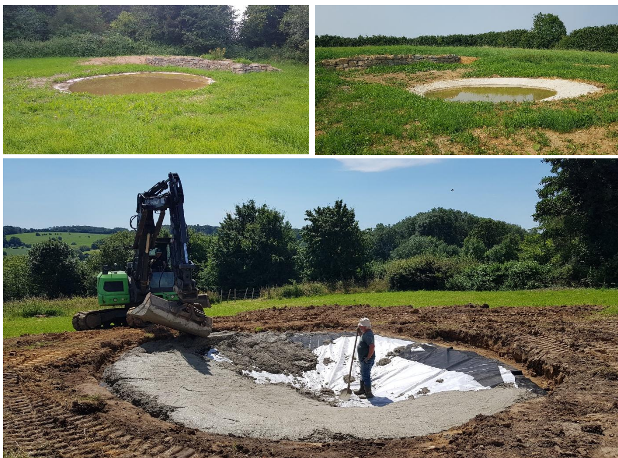
Figuur 8 Nieuw aangelegde poelen en stapelmuren bij Kattenroth (linksboven) en aan de noordzijde van het Noordal (rechtsboven), en de aanleg van de poel aan de noordzijde van het Noordal (foto onder). (Foto's Raymond Tilmans)
