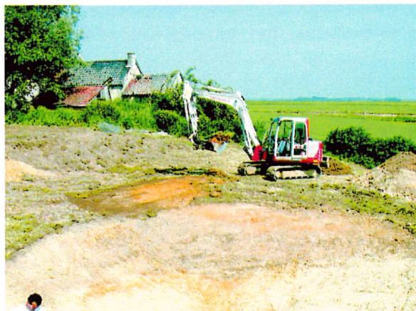
In juni 2004 is door Staatsbosbeheer een basishabitat voor de geelbuik in het gebied Berghofwei, gerealiseerd.
