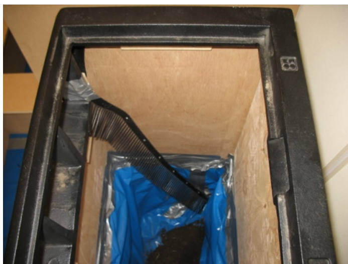
Foto 8: rechthoekige opvangbak met kunststof vogelschroot, uitkomend op de opening van een hoekkolk, bovenaanzicht
