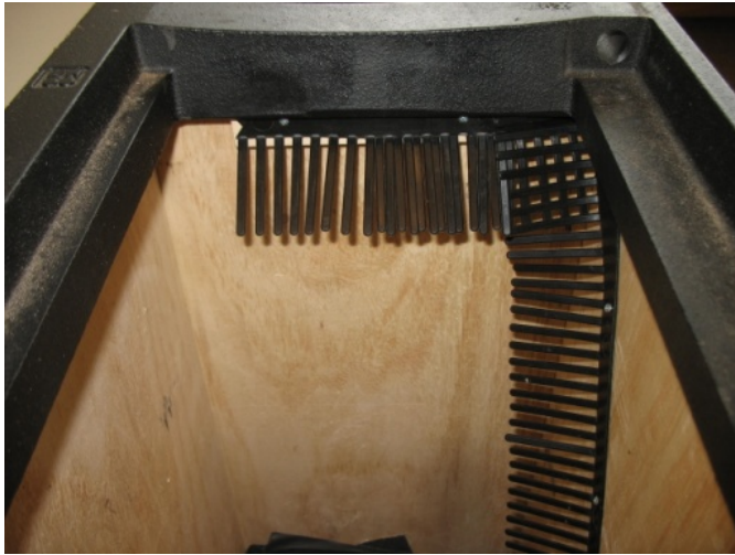
Foto 9: rechthoekige opvangbak met kunststof vogelschroot, eindigend in een platform dat toegang geeft tot de openingen in de (platte) straatkolk
