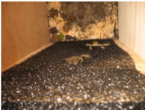
Foto 10: rechthoekige opvangbak onder straatkolk, met begroeiingsmat, bovenaanzicht. Te zien zijn een bruine kikker en een bastaardkikker tijdens het uitklimmen.
