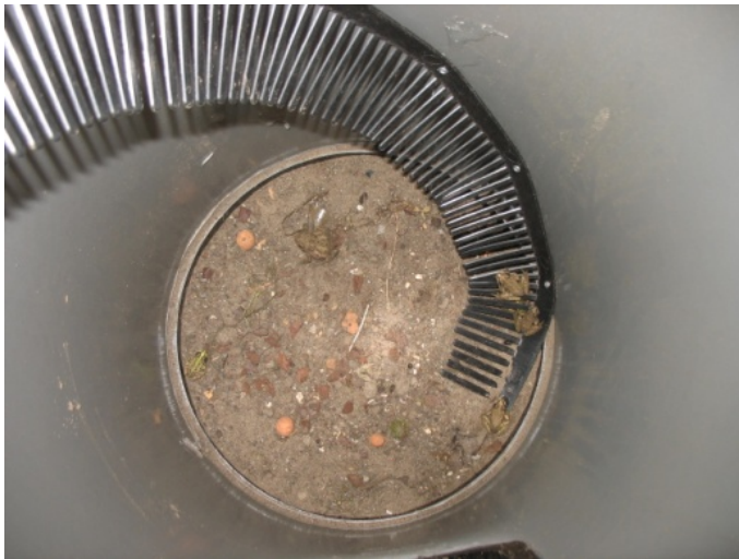
Foto 7: ronde opvangbak met kunststof vogelschroot, bovenaanzicht
