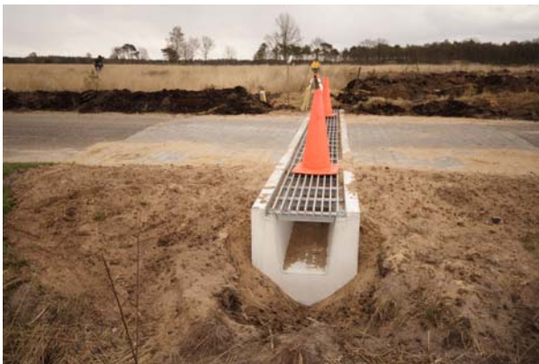
Faunapassage Beerze in aanleg (Foto J. Jansse)
