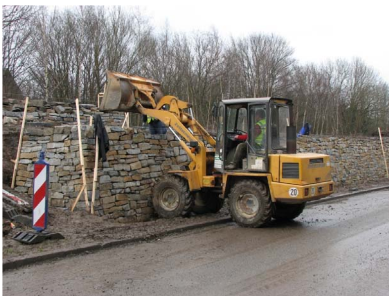
Bouw stapelmuur voor muurbagedis (Foto Frank Spikmans)
