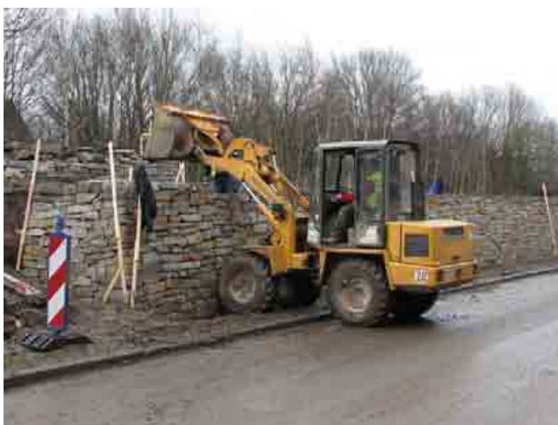
Bouw stapelmuur voor muurbagedis (Foto Frank Spikmans)
