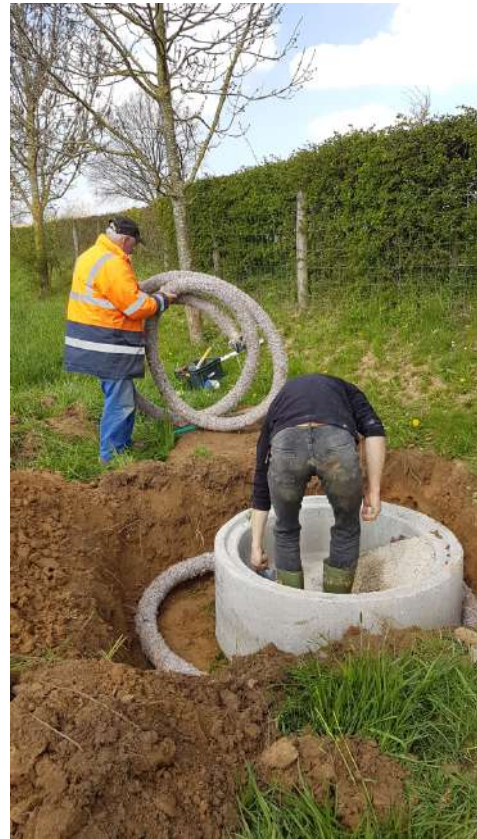
Aanleg aflatbare betonnen bak, de drainagebuis staat garant voor een snelle afvoer van het water in het najaar.
