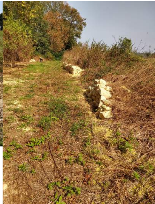
Rechts: Nieuwe stapelmuren in aanbouw op terrein van Ed Gubbels.
