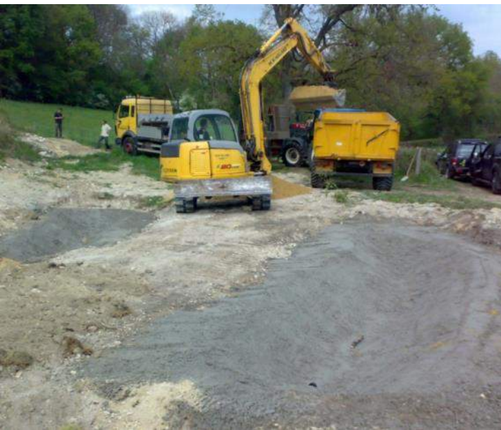
22 april 2014. Onder leiding van Wil Niessen en Ben Crombaghs worden onderaan de Wolfskop twee langwerpige betonnen poelen aangelegd. De Wolfskop vormt een belangrijke stapsteen tussen de natura 2000 gebieden Bemelerberg en Schiepersberg en Savelsbos.
